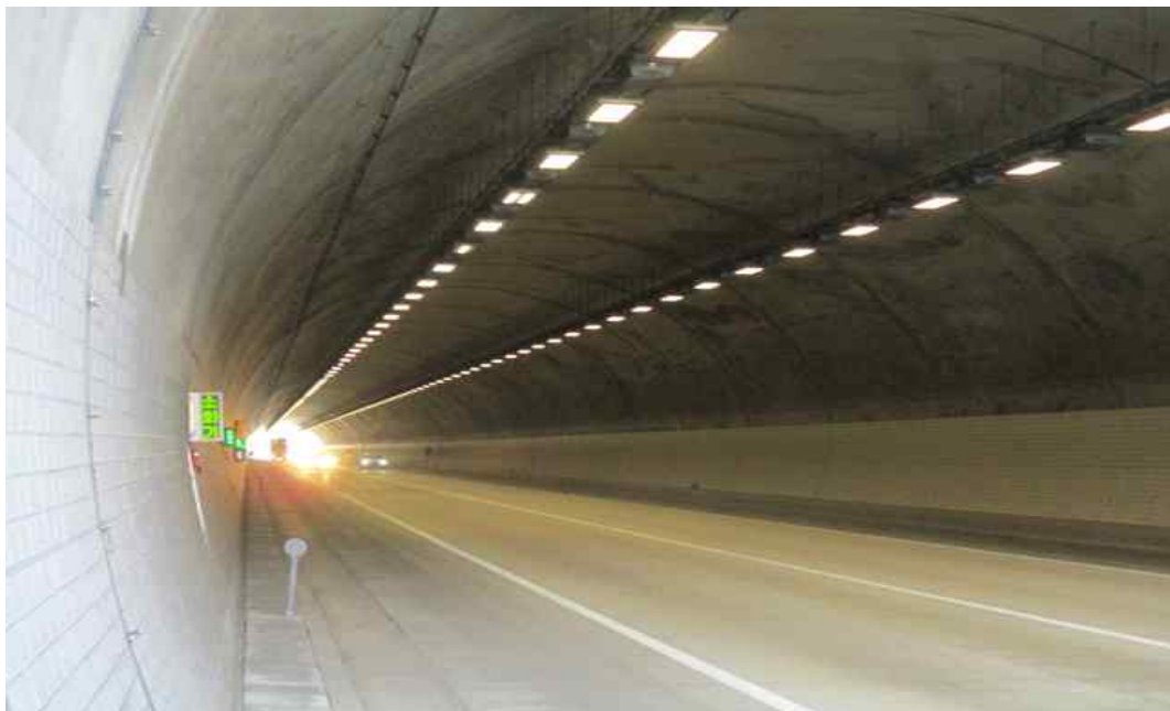
군자1터널(양양) 내부 전경
